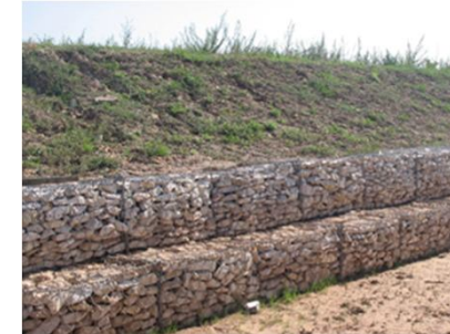
Mur de gabions
